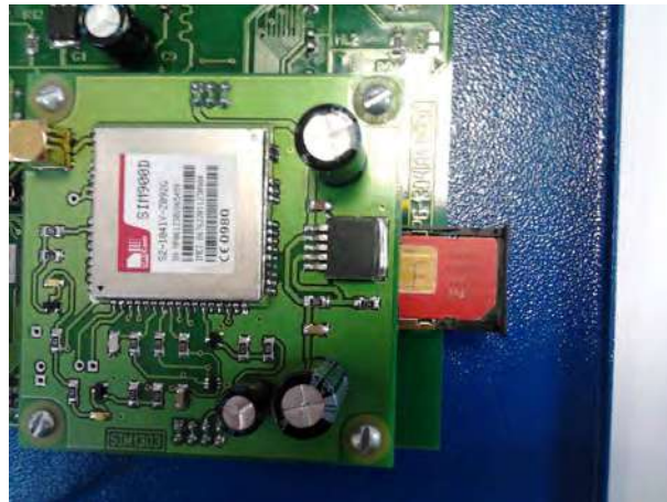
Фото 10.1. Установка лотка на место
