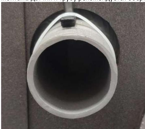
Датчик Шнека – Датчик аварийной температуры шнека (Крепится на корпусе шнека подачи топлива)
