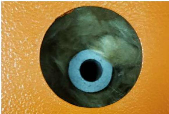
Термик – Аварийный датчик температуры котла (Крепится на верхнем металлическом патрубке подачи на задней стенке котла или непосредственно на верхней поверхности водяной рубашки тела котла) После монтажа датчик и трубу рекомендуется обернуть утеплителем!
