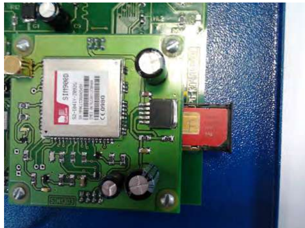
Фото 12.1. Установка лотка на место
