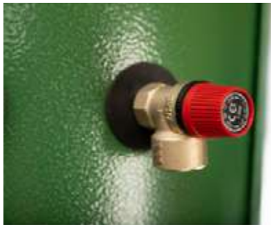
Рис. 18 Установка клапана безопасности
