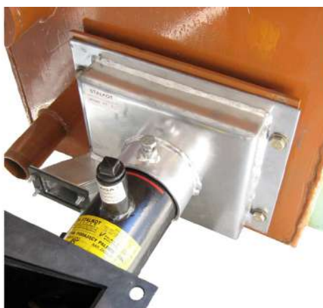
Рисунок 3 – Место установки механизма подачи топлива
