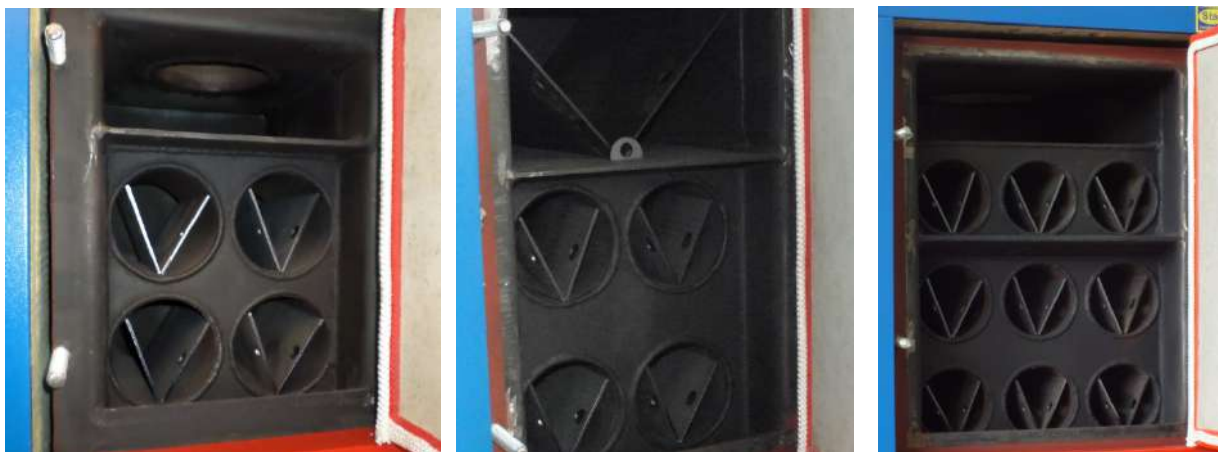
Рисунок 4 – Схема установки турбулизаторов
