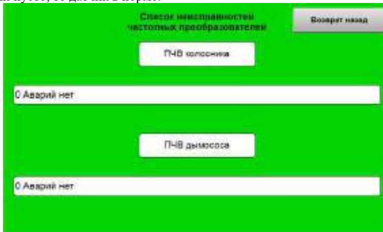
Рис 6.10. Экран состояния ПЧВ.
