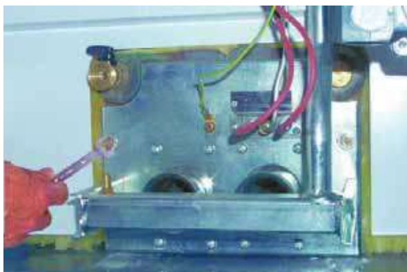
рис. 22 - Демонтаж горелок
