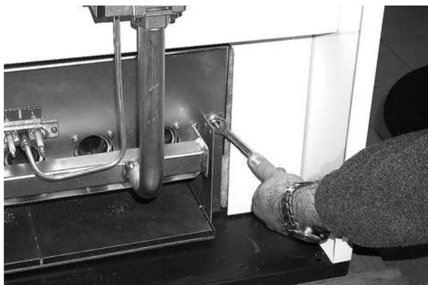
рис. 10 - Развинтите гайки крепления камеры сгорания
