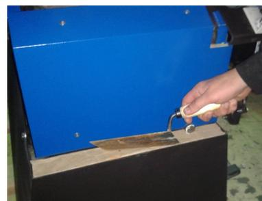
4.8 После того, как корпус котла установлен на запланированное место, проверьте его положение по двум направлениям.
