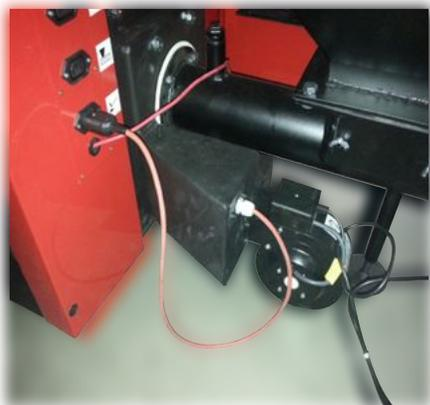
6. Затянуть все болты и подключить шнур питания. Проверить работу устройства.
